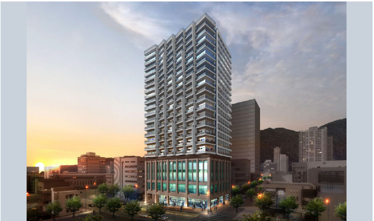
● 더베이먼트 - 테라스스위트 철거 및 신축공사 착공 : 21년 11월 / 준공예정 : 24년 06월 규모 : 지하 4층 ~ 지상 20층 연면적 : 20,572.39㎡(6,223.14평)
