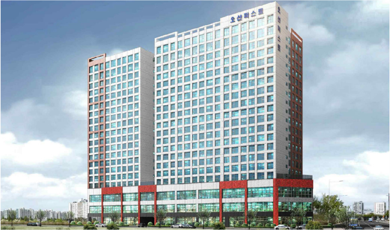
● 오션퍼스트 신축공사(부산) 착공 : 22년 02월 / 준공예정 : 24년 06월 규모 : 지하2층 ~ 지상20층 연면적 : 50,657.55㎡(15,323.91평)
