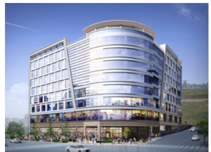
● 웅천 금성타워 신축공사(여수) 착공예정 : 21년 하반기 규모 : 지하 2층 ~ 지상 7층 연면적 : 24,535.29㎡(7,421.93평)
