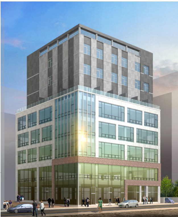
● 검단 국제프라자 2차 신축공사(인천) 착공 : 21년 06월 / 준공예정 : 22년 09월 규모 : 지하 4 ~ 지상 8층 연면적 : 8,474.60㎡(2,563.57평)
