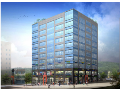
● 금성스퀘어 신축공사(원주) 착공예정 : 21년 하반기 규모 : 지하 2층 ~ 지상 10층 연면적 : 13,382.97㎡(4,048.35평)
