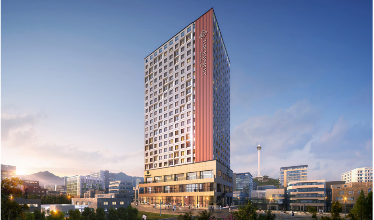
● 남포동 더베이먼트 - 비프에비뉴99 신축사업 착공 : 20년 11월 / 준공예정 : 23년 05월 규모 : 지하 2층 ~ 지상 20층 연면적 : 13,111.3㎡(3,966.16평)
