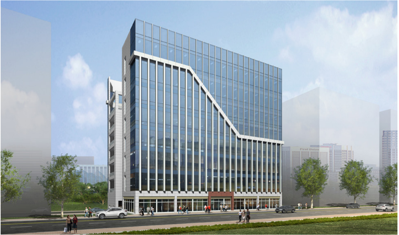
● 검단 제일프라자 신축공사(인천) 착공 : 21년 01월 / 준공예정 : 21년 02월 규모 : 지하 3층 ~ 지상 8층 연면적 : 9,707.46㎡(2,936.46평)
