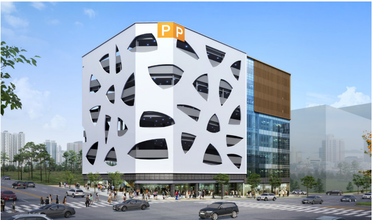
● 동탄 주차빌딩 52 신축공사 착공 : 22년 05월 / 준공예정 : 23년 11월 규모 : 지하1 ~ 지상8층 연면적 : 12,333.03㎡(3,730.74평)
